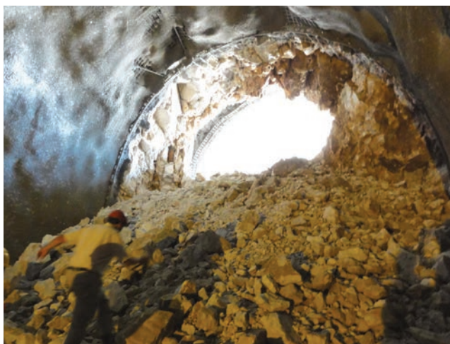
Trenutak probouja tunelske cijevi
