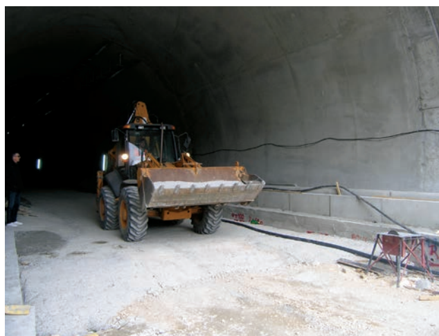
Radovi druge faze u tunelu
