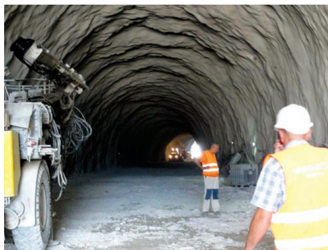
Uređivanje tunela za privremeno puštanje u promet
