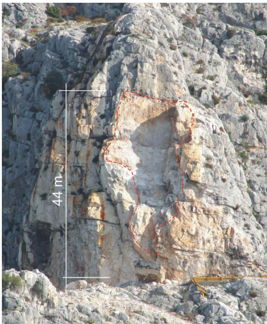
Dio padine s koje se odlomila kamena gromada (S. M. Kovačević: Dani podzemne gradnje 2011. )
