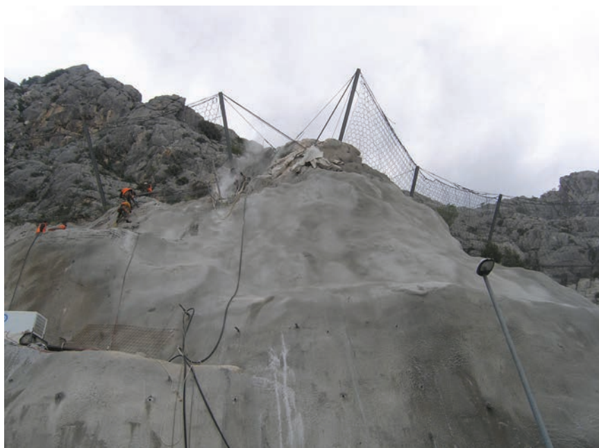
Zaštita pokosa pokraj istočnog portala
