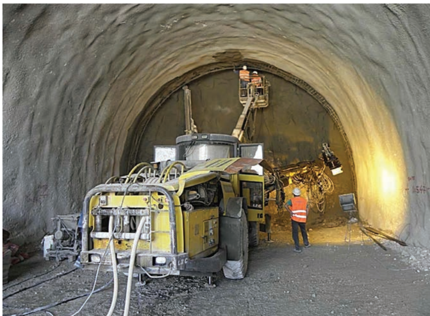
Bušenje tunelske cijevi
