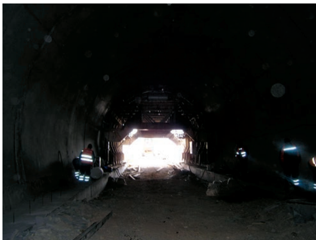
Radovi na istočnom portalu tunela
