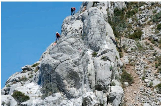
Zaštita blokova mrežama i čeličnom užadi
