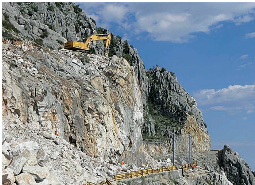
Rušenje dijela nestabilnih blokova
